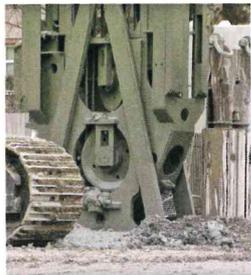
Ende Juni herrschte Hochbetrieb auf dem 10.000 m<sup>2</sup> großen Bauplatz für das neue LDZ. Unter anderem standen drei Bohrgeräte im Einsatz, darunter zwei Bauer BG 45. Bis zu 30 Fahrmiter versorgten pro Tag die Bohrpfahlerstellung auf der Baustelle.
