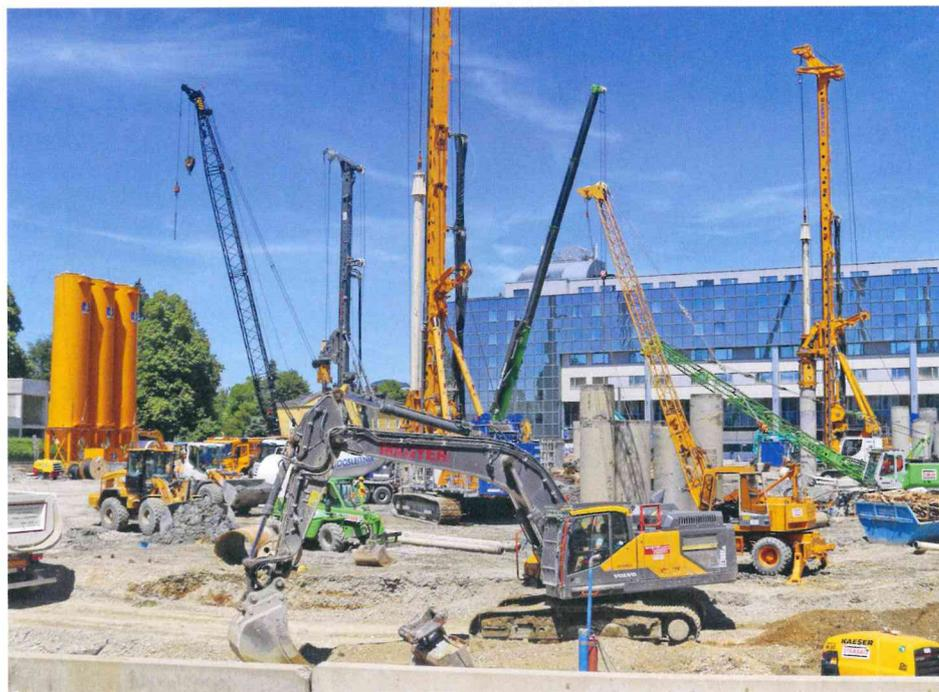
In der heißen Tiefbauphase waren im Schnitt 16 Bagger, 12 Lkw, vier Mobilkräne, vier Teleskoplader und 36 Fahrmischer im Einsatz.
