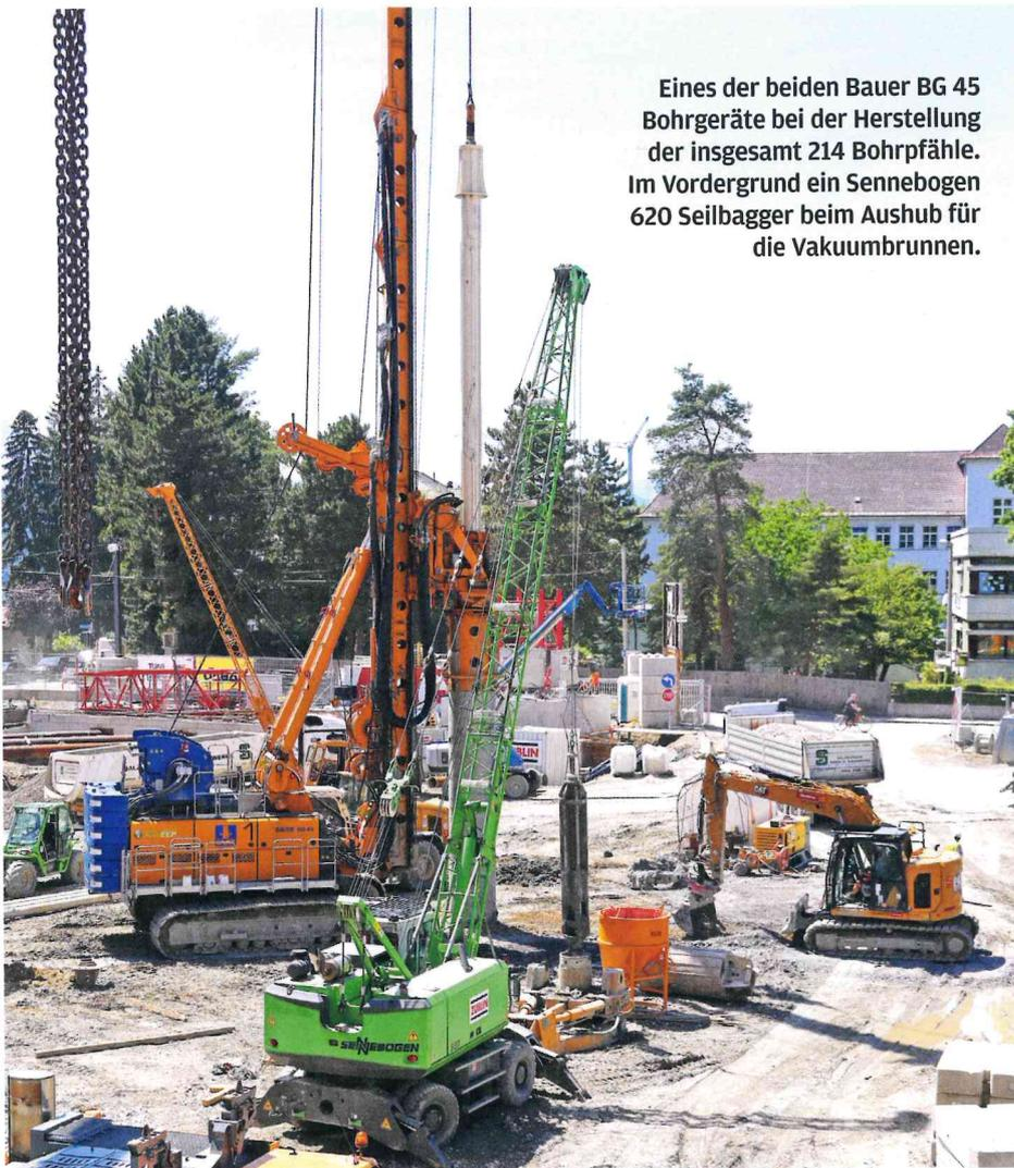
Eines der beiden Bauer BG 45 Bohrgeräte bei der Herstellung der insgesamt 214 Bohrpfähle. Im Vordergrund ein Sennebogen 620 Seilbagger beim Aushub für die Vakuumbrunnen.
